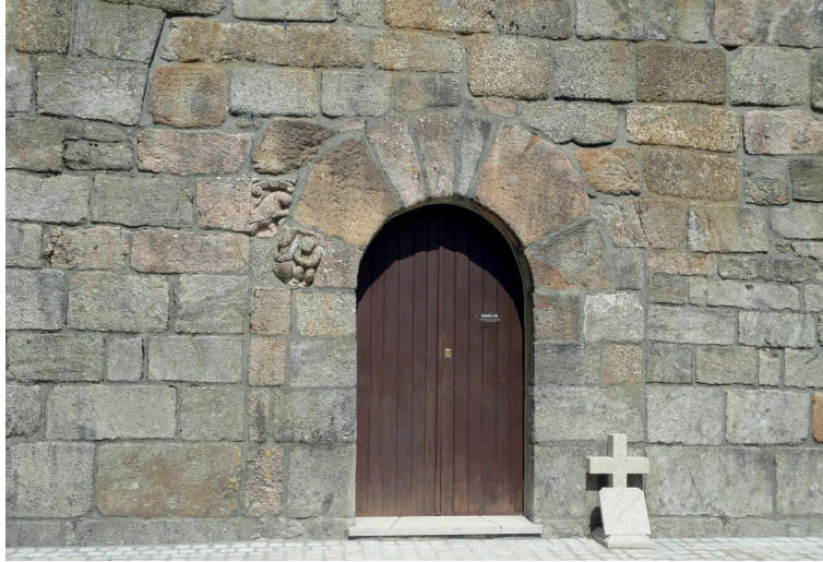
Figura 3 Porta principal da igreja de Lamas de Mouro. Autor: majosilveiro.
